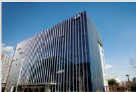
안양 R&D캠퍼스 산업용 전기·전자의 기초분야, 자동화 제어기기 관련분야
