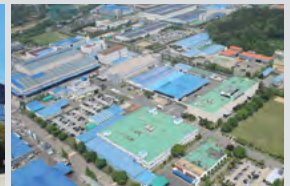
청주 사업장 전력기기(MCCB, ACB, VCB, 몰드TR 등) 및 수배전반, 초고압기기(GIS, Oil-TR)
