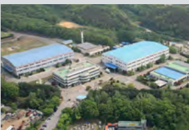
천안 사업장 자동화(PLC, AC Drive, HMI, DCS, 태양광모듈)
